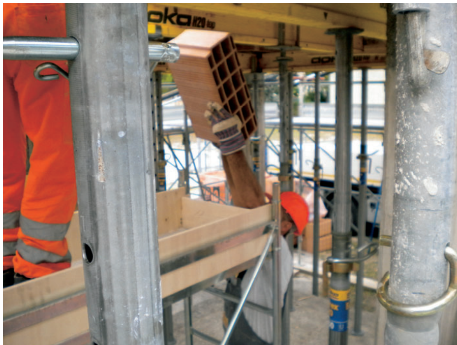
Figura 18 – Fase del passaggio delle pignatte dal basso
