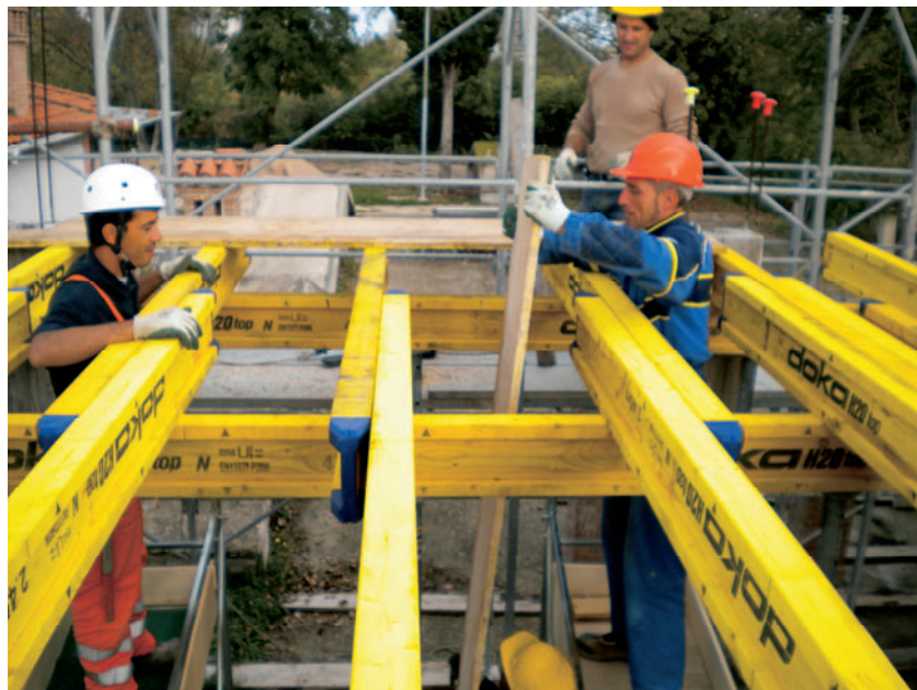
Figura 48 – Fase di montaggio del tavolato
