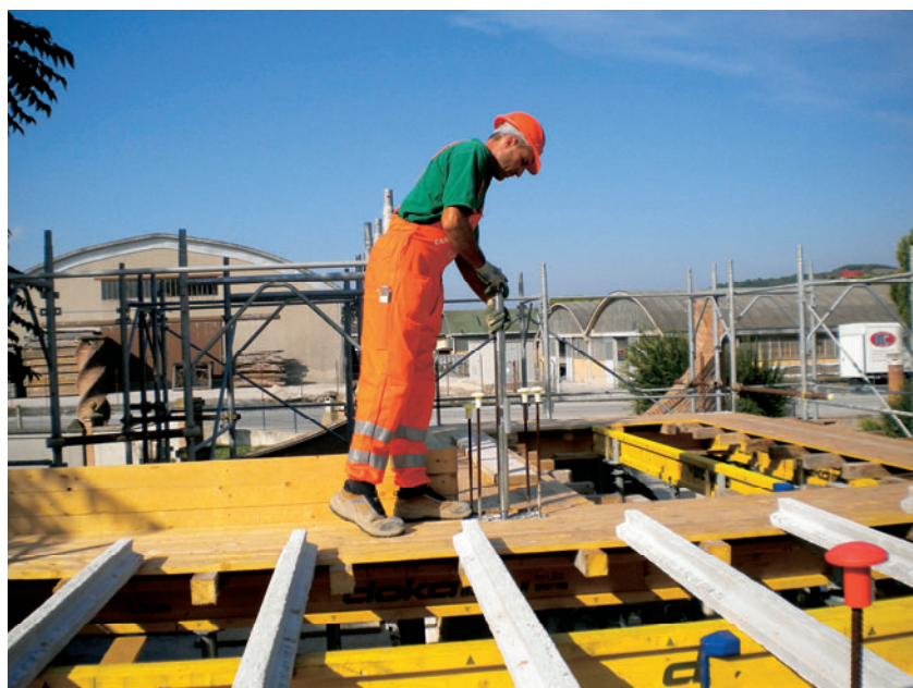
Figura 32 – Inserimento di un'asta nella boccola
