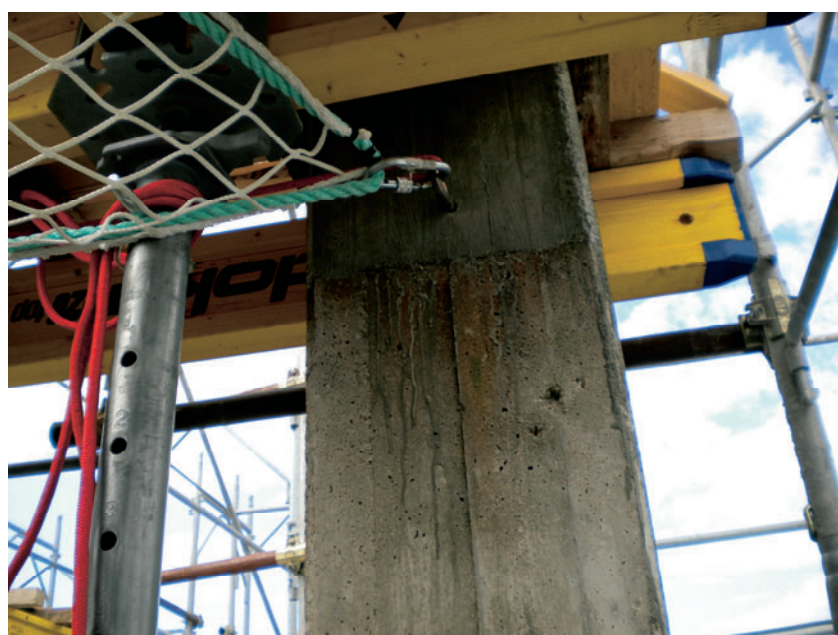
Figura 25 – Dettaglio dell'ancoraggio d'angolo della rete al pilastro
