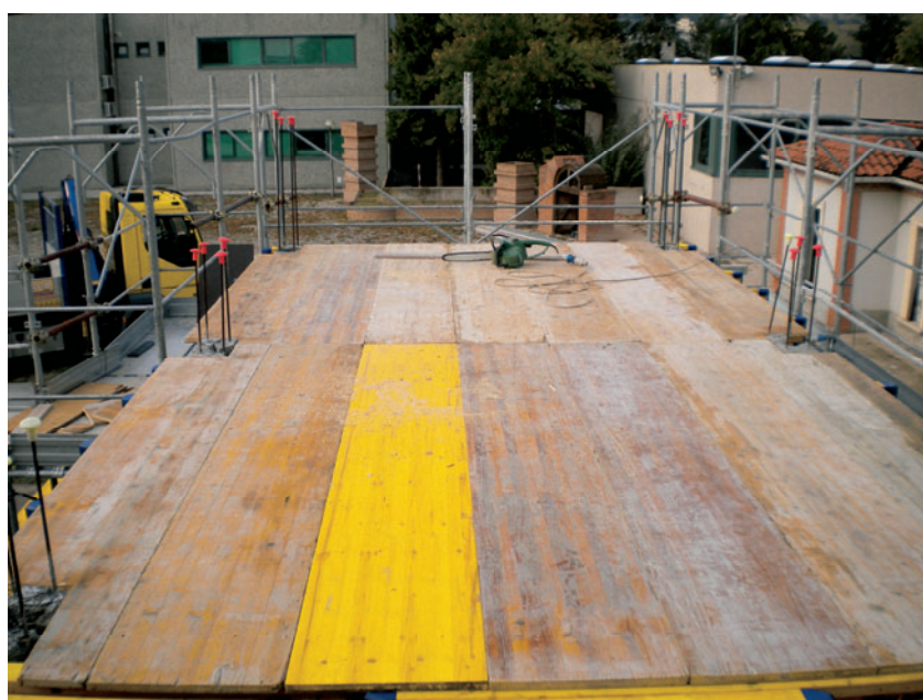
Figura 49 – Banchinaggio ultimato
