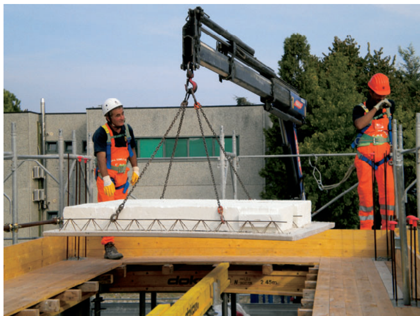
Figura 41 – Operai nella posa della prima lastra con imbracatura anticaduta e cordino agganciato al ponteggio di facciata.
