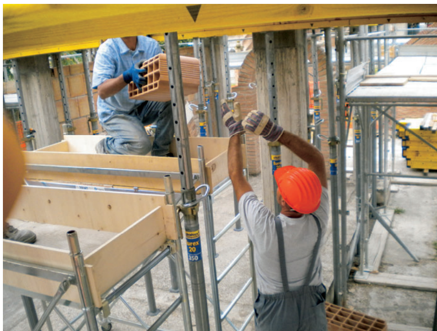
Figura 19 – Fase del passaggio delle pignatte dal basso
