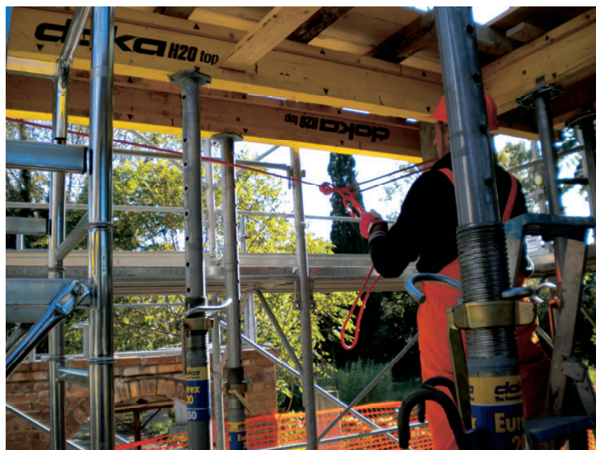
Figura 24 – Montaggio della fune di bordo ai pilastri
