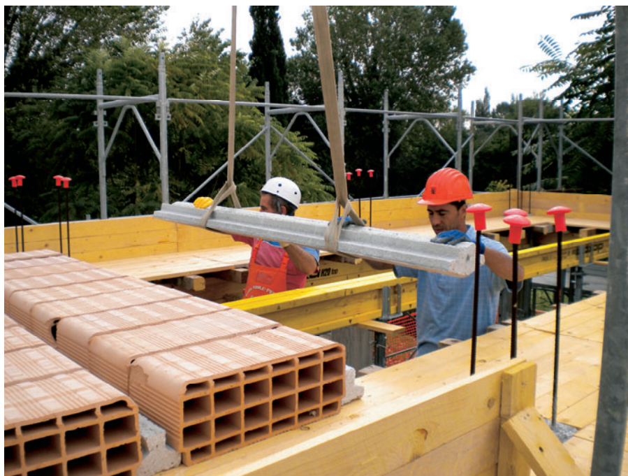
Figura 17 – Fase di posa in opera dei travetti
