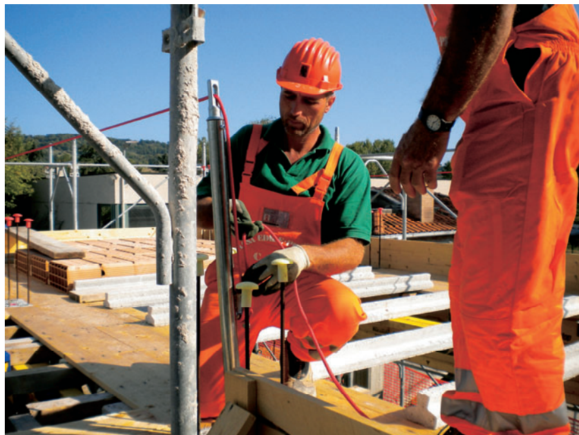
Figura 33 – Fase di ancoraggio della fune tessile
