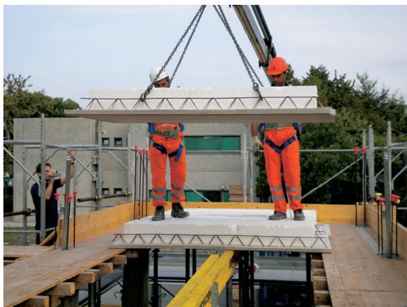
Figura 43 – Fase della posa delle lastre
