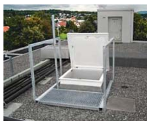
3 Accesso sicuro al locale macchine
