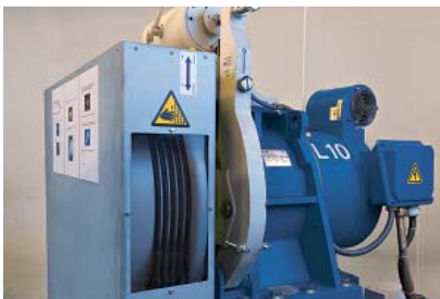
1 Puleggia motrice con cuffia di protezione
