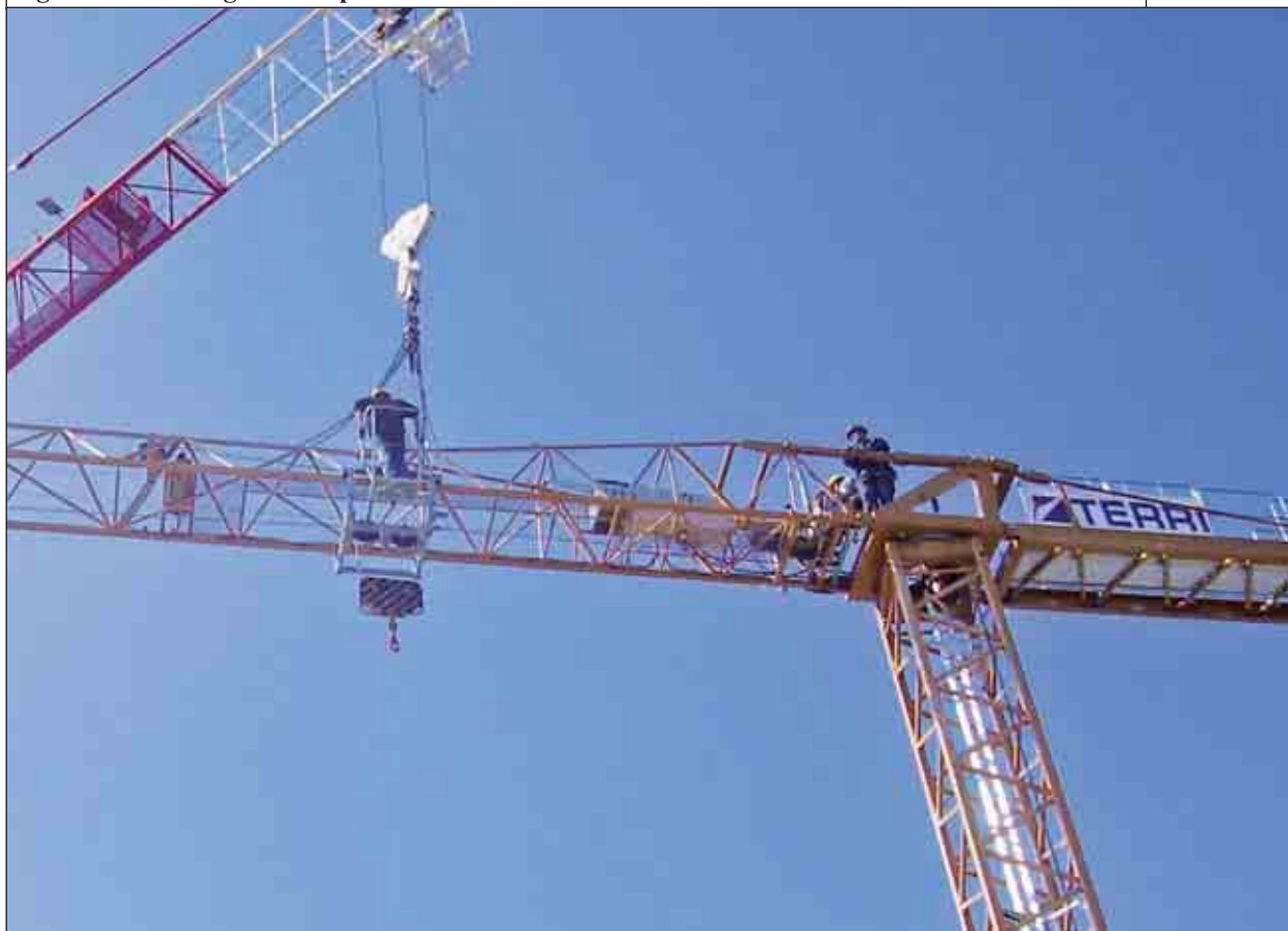
Sgancio delle braghe dall'operatore a bordo del ballatoio installato sul carrello di sollevamento
