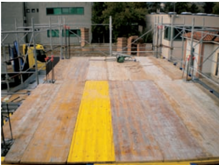
Figura 49 – Banchinaggio ultimato
