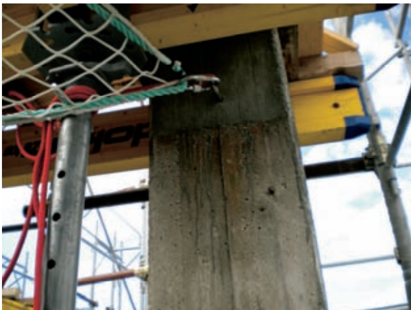
Figura 25 – Dettaglio dell'ancoraggio d'angolo della rete al pilastro
