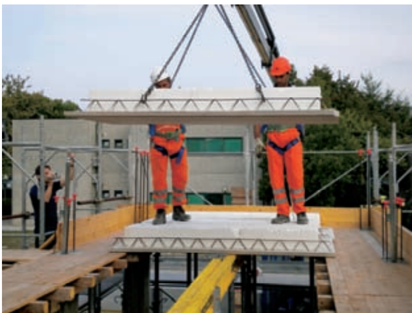
Figura 43 – Fase della posa delle lastre
