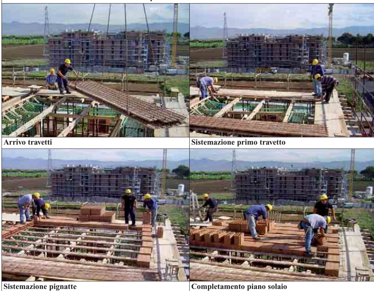
Sequenza realizzazione solaio
