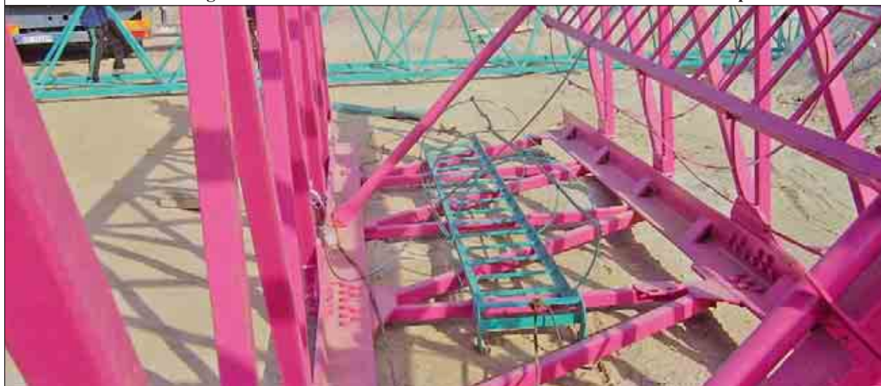
Elementi di torre ancora giacenti sul terreno. All'interno sono visibili le scale verticali sistemate provvisoriamente
