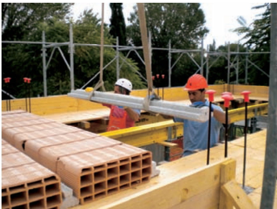
Figura 17 – Fase di posa in opera dei travetti
