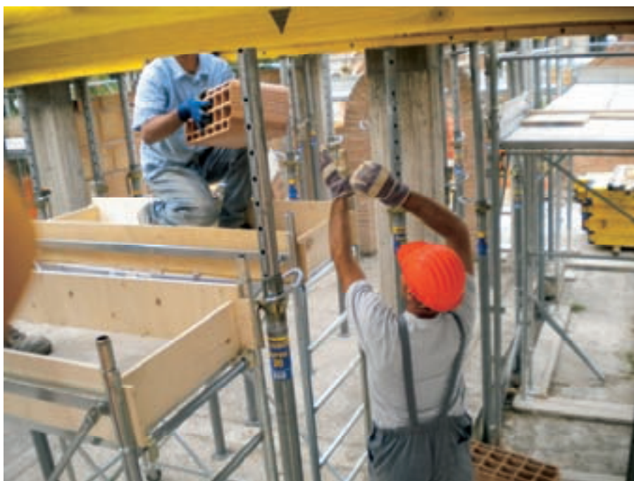
Figura 19 – Fase del passaggio delle pignatte dal basso
