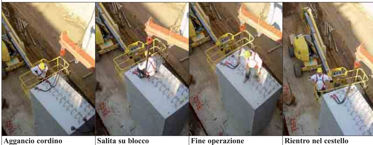
Sequenza sgancio imbracature in quota con cestello e lavoratore con imbracatura
