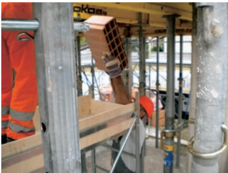
Figura 18 – Fase del passaggio delle pignatte dal basso
