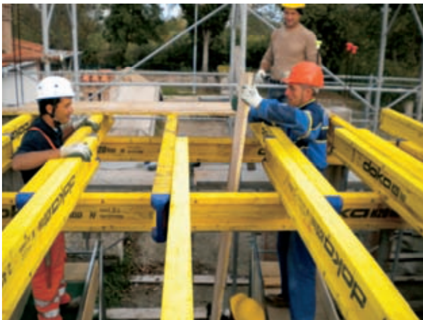
Figura 48 – Fase di montaggio del tavolato
