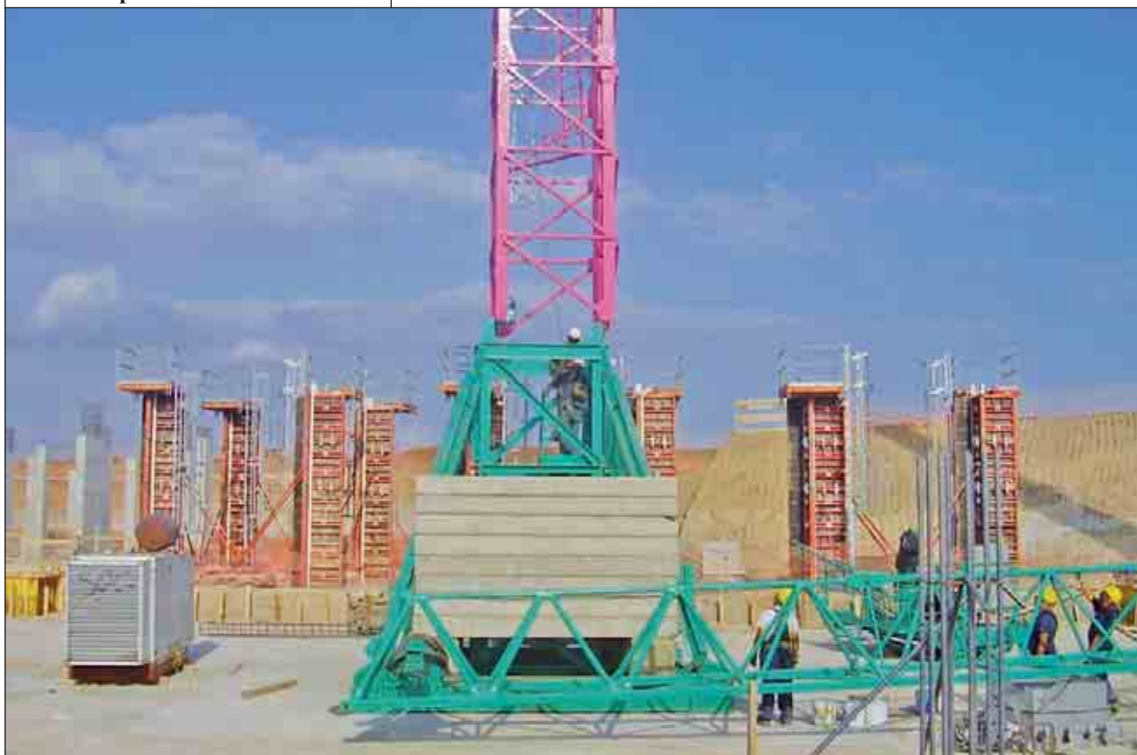
Preso del primo elemento di torre
