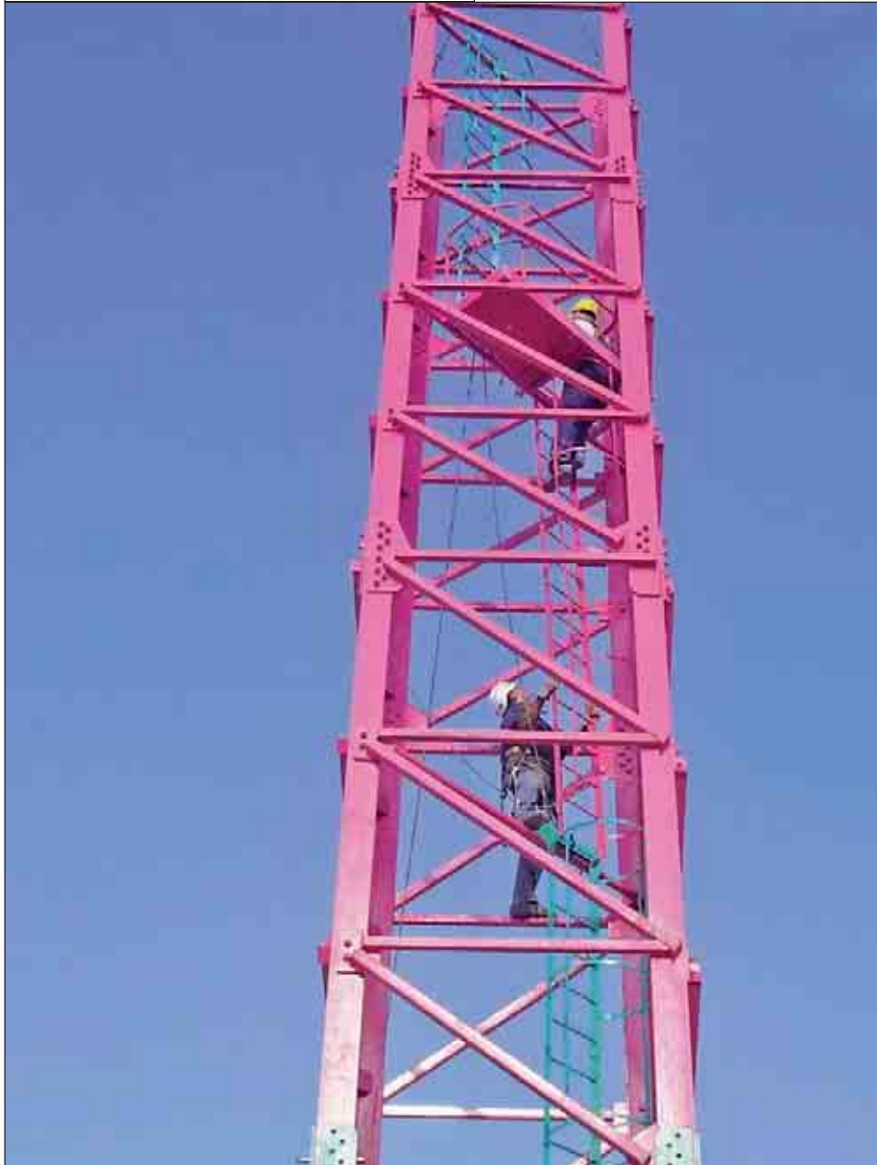
Risalita di un elemento dopo il montaggio
