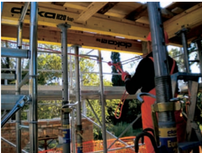
Figura 24 – Montaggio della fune di bordo ai pilastri
