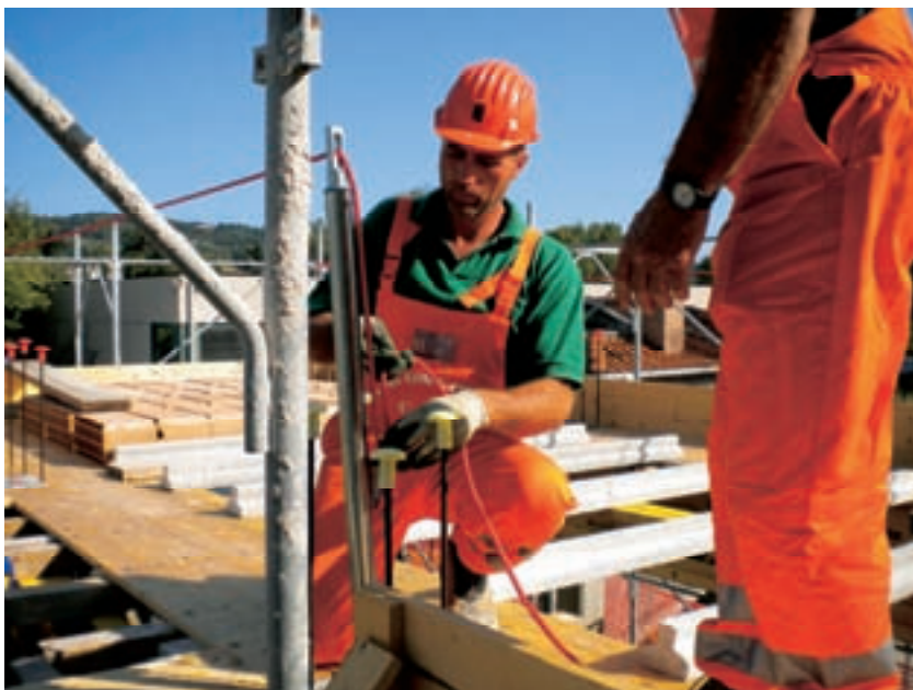
Figura 33 – Fase di ancoraggio della fune tessile
