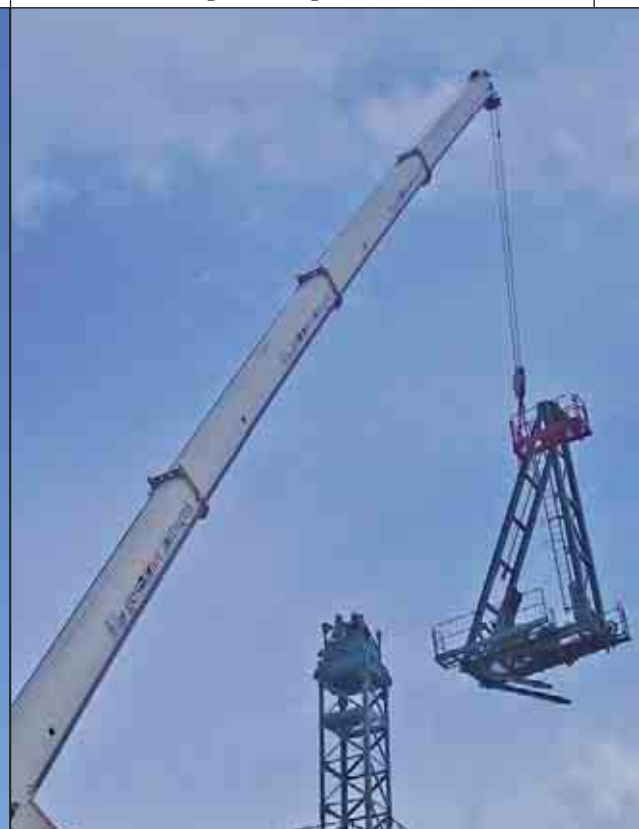
Arrivo della cuspide con parte del controbraccio
