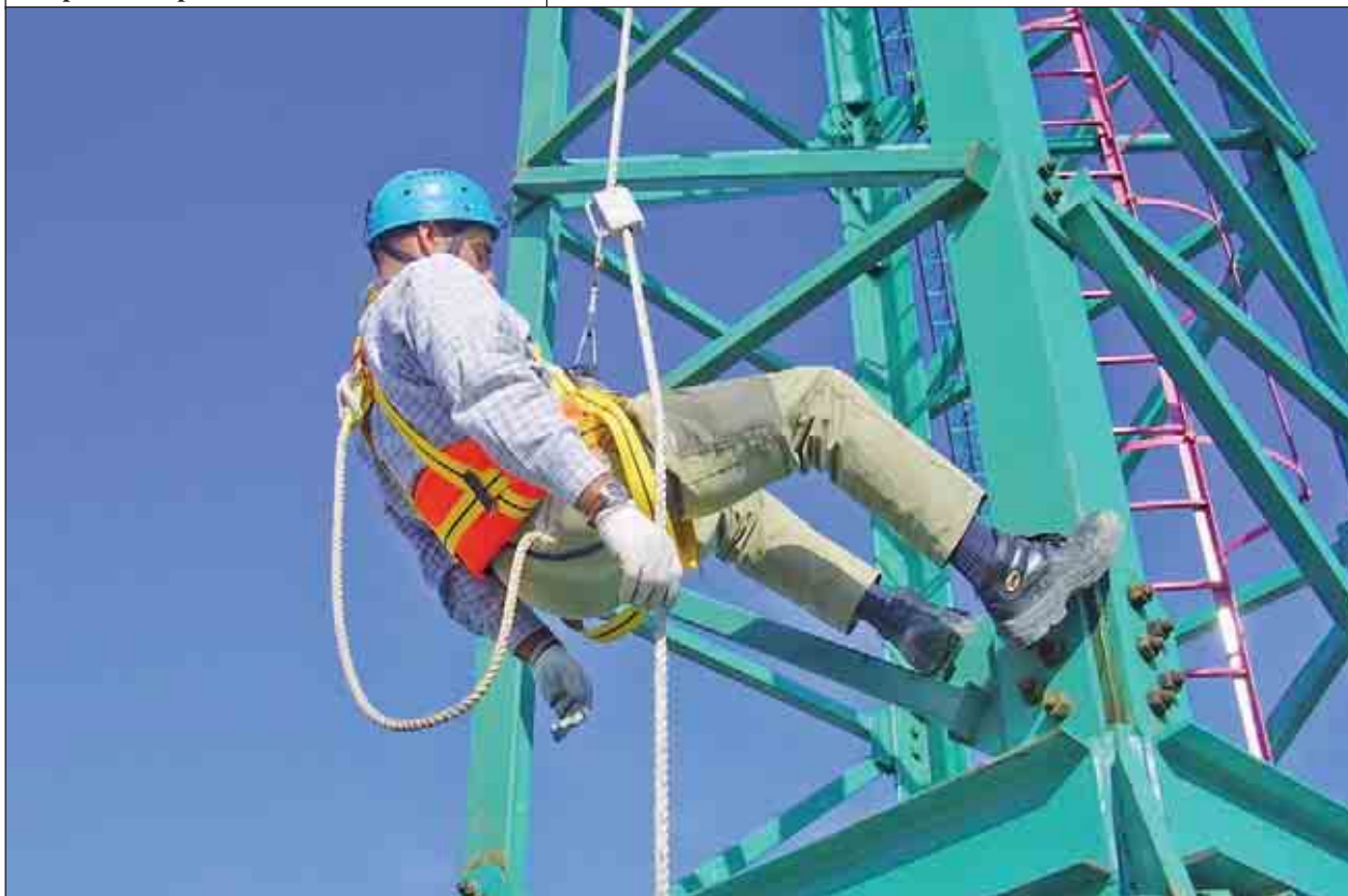
Sospensione passiva con attacco sternale
