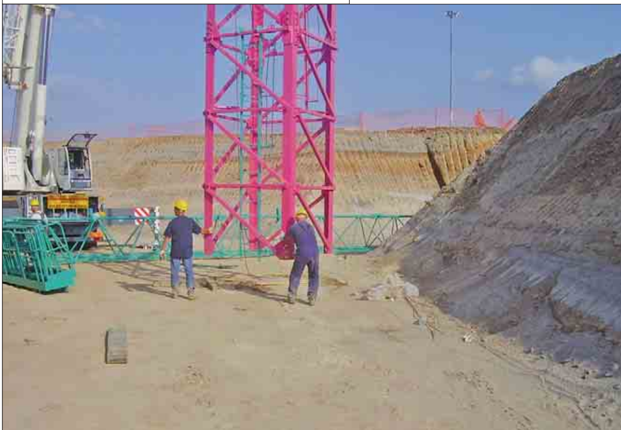
Prima fase di sollevamento: 3 - Stabilizzazione dell'elemento
