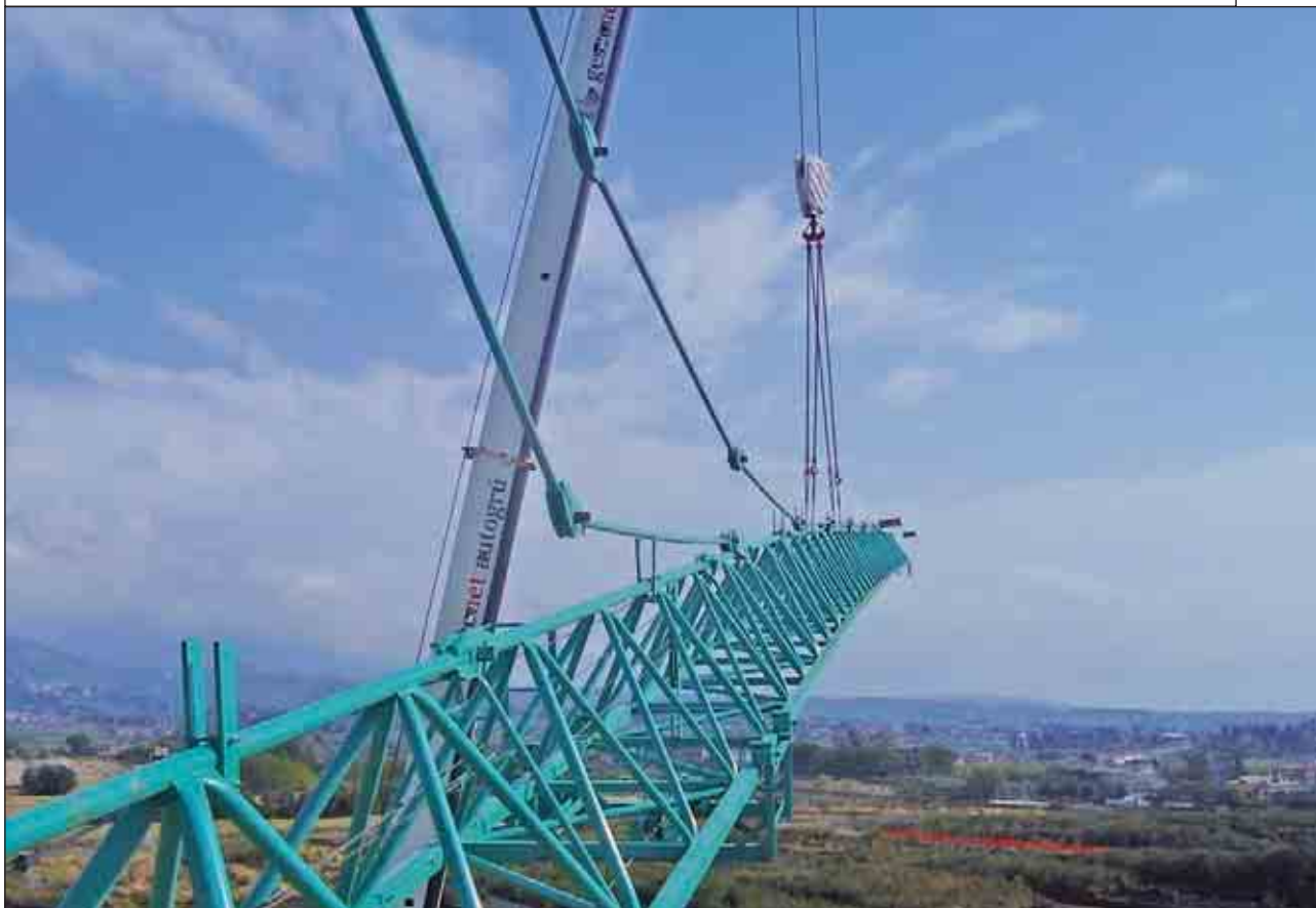
Il braccio, ormai montato, è ancora sostenuto dall'autogrù. Il sistema di aggancio è visibile sullo sfondo
