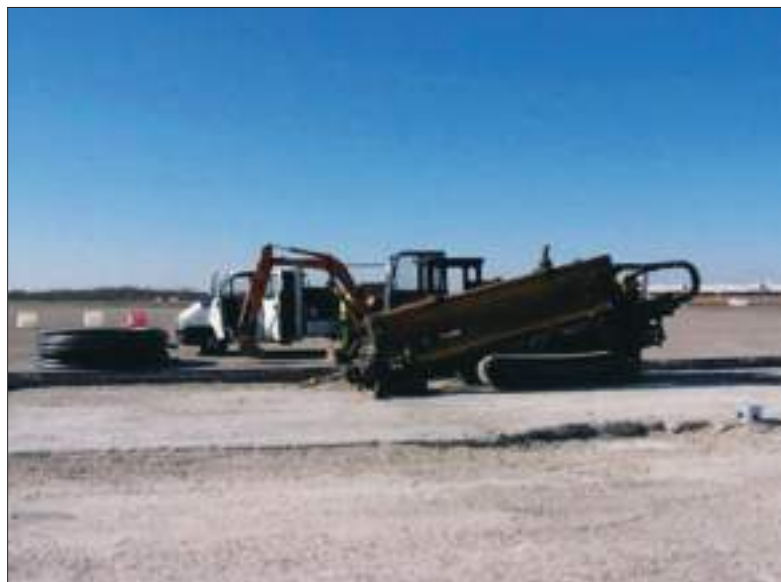
Fig. 5: Perforatrice montata su carro cingolato (Fonte 1)
