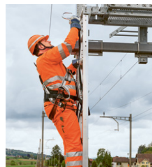
4 Lavori su un palo segnalatore con i DPI anticaduta
