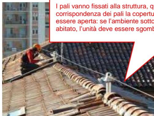
Esempi di csd. "linee vita", sistemi di ancoraggio costituiti da cavi in acciaio trattenuti da pali;
