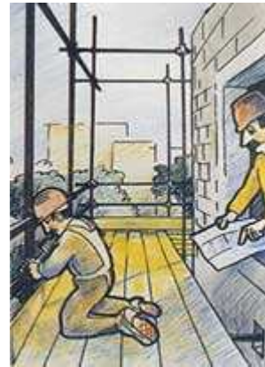
predisposizione di un parapetto a norma
