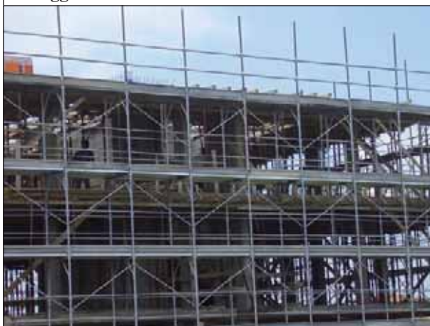
Ponteggio metallico in fase ultimazione cemento armato
