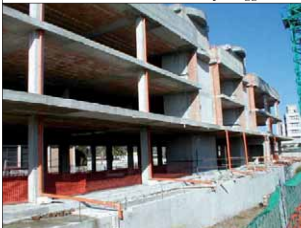
Struttura in cemento armato senza ponteggio
