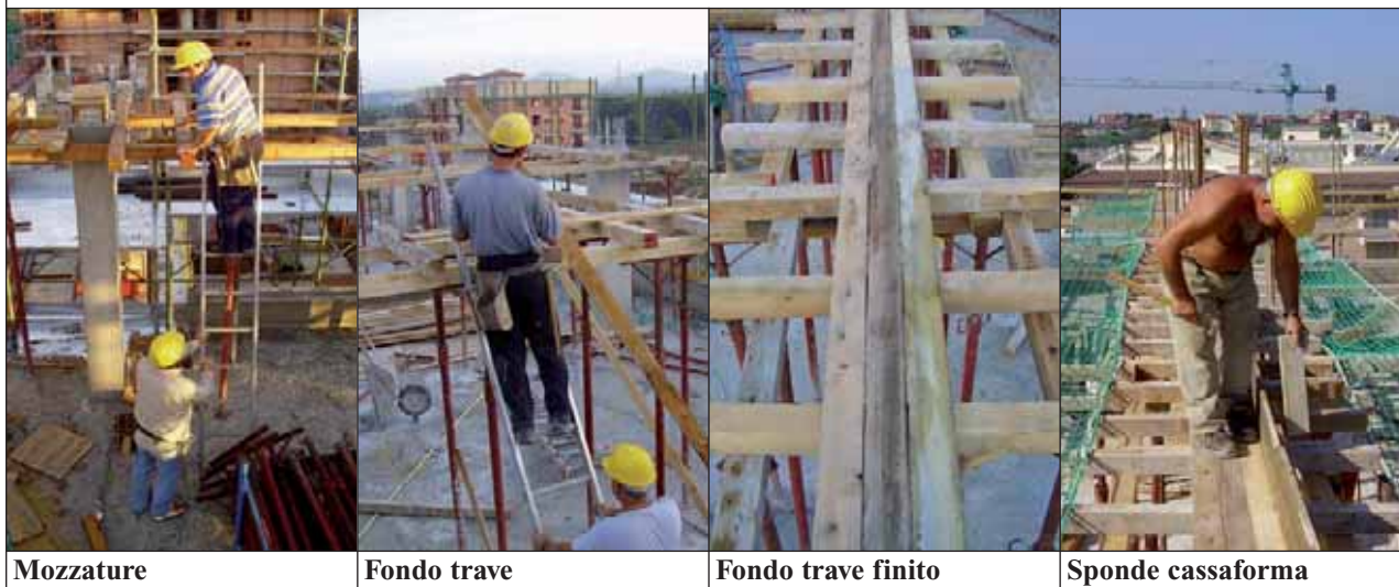
Sequenza immagini nella costruzione della cassaforma di una trave ribassata (a cassetta)
