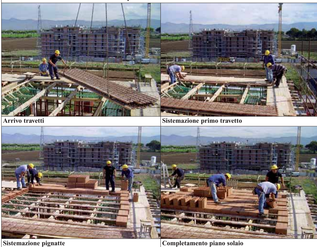
Sequenza realizzazione solaio
