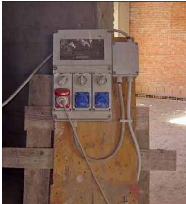
Quadretto elettrico di cantiere IP 44
