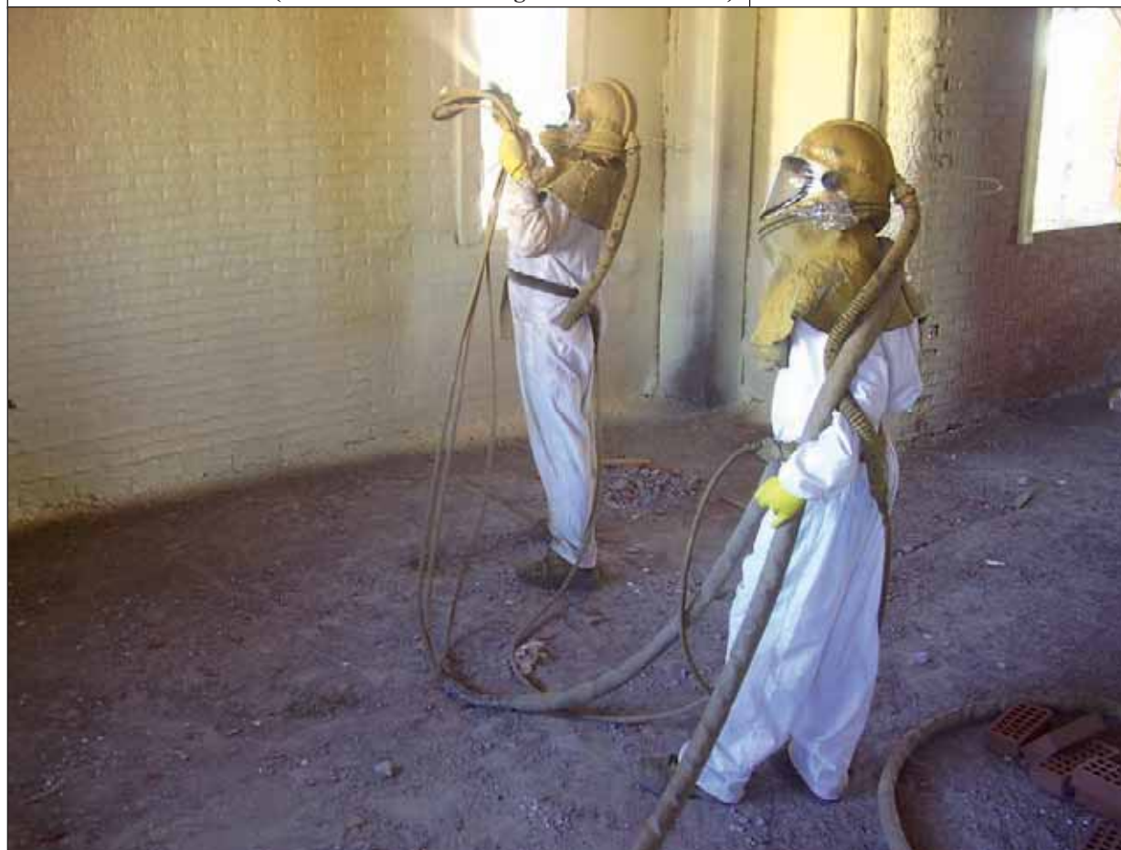
Primo strato di isolante (sono ancora visibili le giunzioni dei laterizi)
