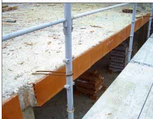
Tavellina d'isolamento termico su fronte solaio
