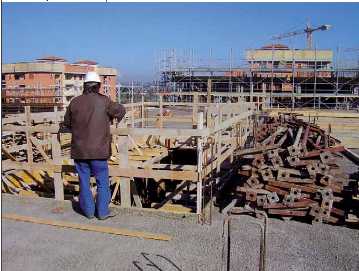
Protezione apertura di solaio
