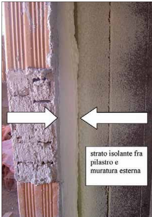
Isolamento termico delle murature esterne
