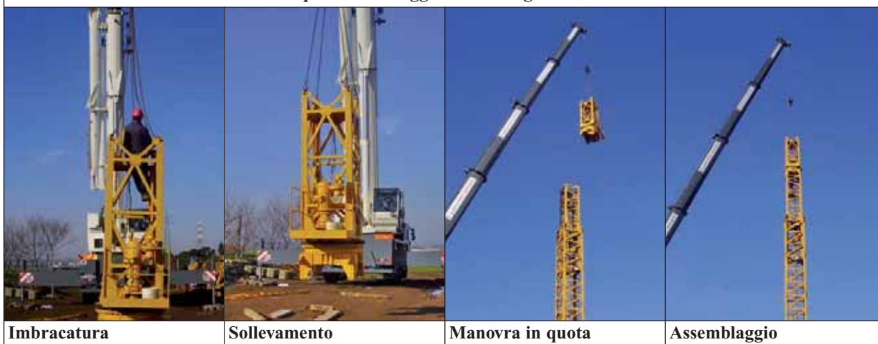
Sequenza montaggio elemento gru a torre
