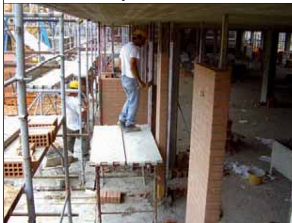
Ponte a cavalletto a piano terra
