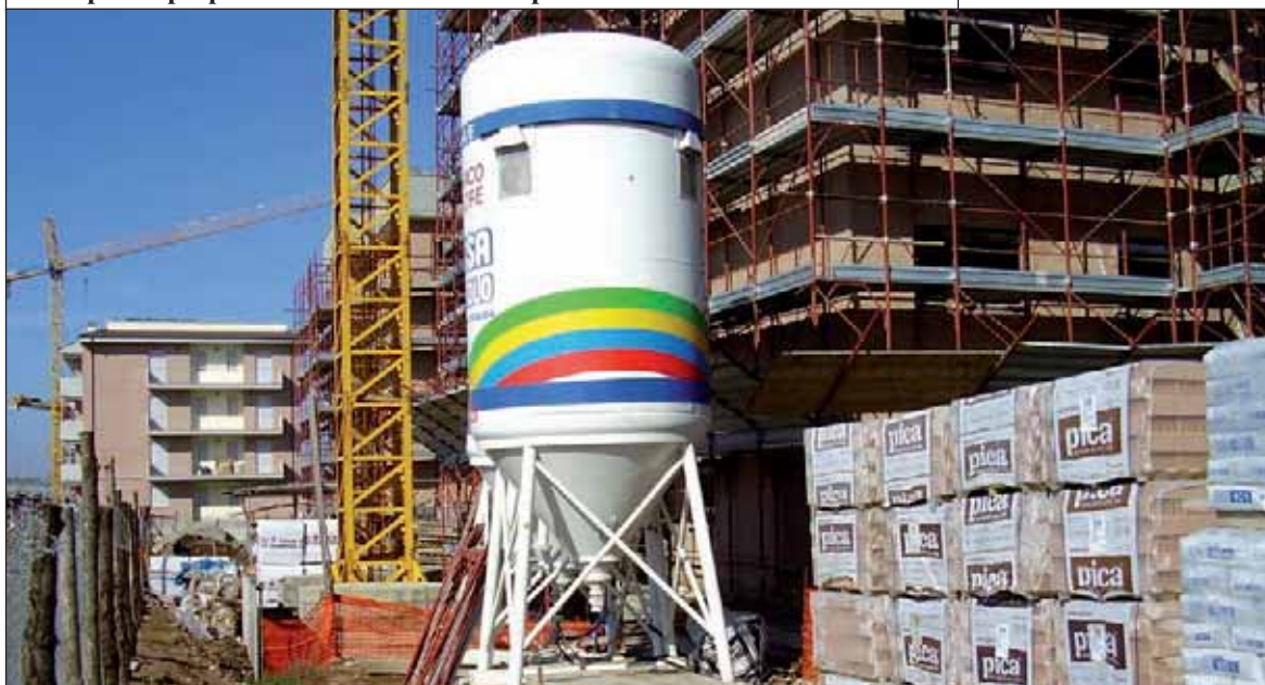
Silos per la preparazione delle malte e deposito laterizi e sacchi di malta
