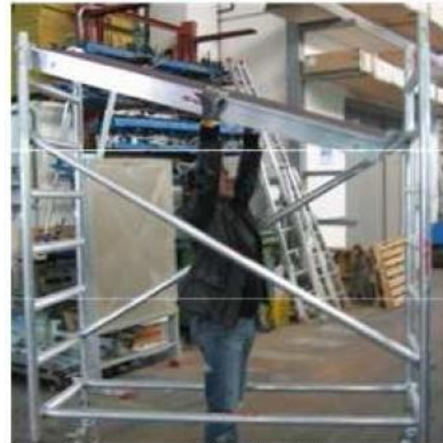
Fig.9: Montaggio del piano di lavoro
