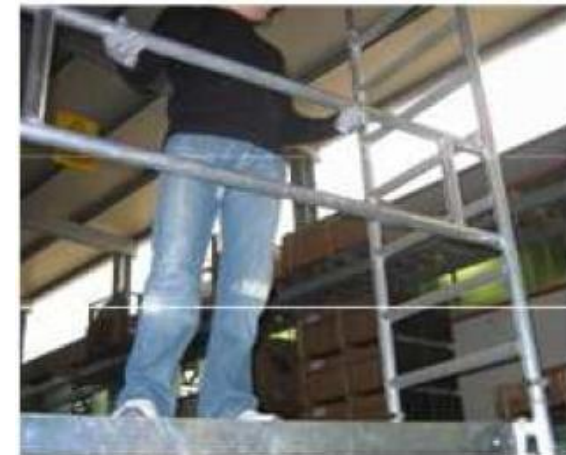
Fig.15: Inserimento dei parapetti
