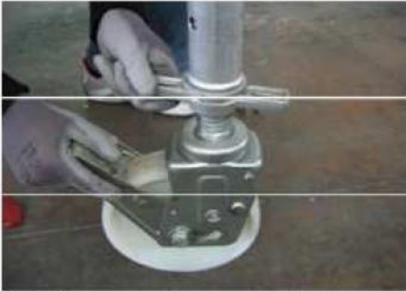
Fig.7: Livellamento del ponteggio mobile
