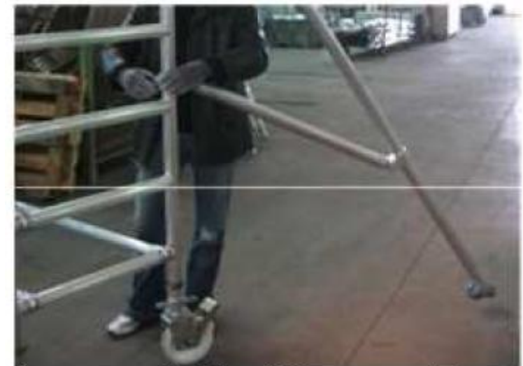
Fig.11: Montaggio dello stabilizzatore - Particolare 2
