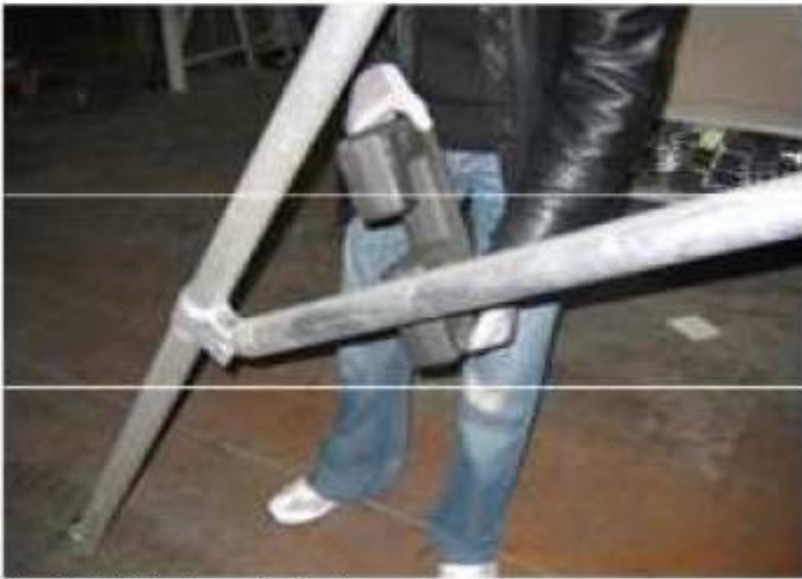
Fig.12: Montaggio delle zavorre
